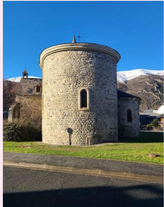
En collaboration avec un architecte du Patrimoine, la commune a procédé au traitement des fissures verticales sur l'abside de la chapelle et à la reprise d'une partie de la charpente. Le coût de ces travaux s'est élevé à 124 000 € subventionné à hauteur de 20 000 € par l'État.
