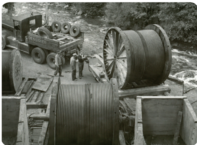
Les câbles du téléphérique
