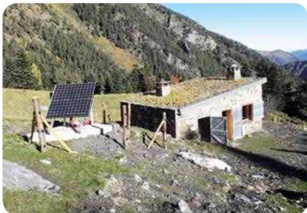
Ces travaux ont consisté à l'aménagement de sanitaires et à l'installation d'un réseau d'assainissement et d'un réseau électrique photovoltaïque dans chaque cabane. Grâce au captage d'une source, la cabane d'Arêt a pu être alimentée en eau potable.
