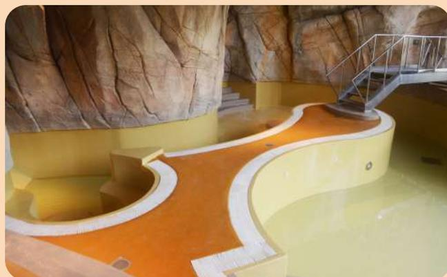
Cet automne, des travaux de peinture et d'étanchéité dans tous les bassins du Rio et de rénovation de l'ensemble des plages intérieures ainsi que l'installation d'un nouveau système de climatisation dans les cabines de massage ont été financés par la commune. L'installation de la Gestion Technique Centralisée (GTC), système qui permet de disposer d'une vision d'ensemble pour réguler la température, le Ph et le chlore de l'eau de chacun des bassins par ordinateur est en cours de finalisation.
