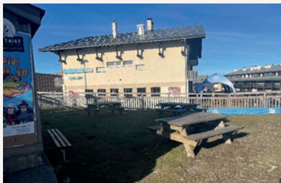
Renforcement des tables de pique-nique
