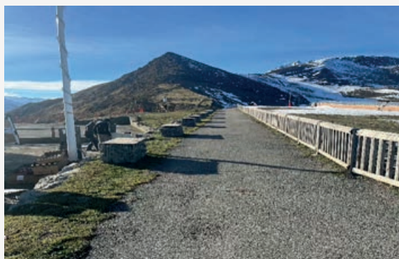
Mise en place de bancs en gabion
